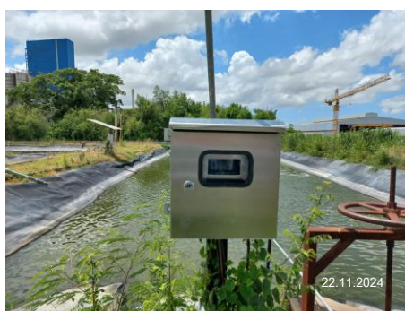
ภาพที่ 2.2-59 การติดตั้งอุปกรณ์ตรวจวัดค่าความนำไฟฟ้า (Conductivity Analyzer)
