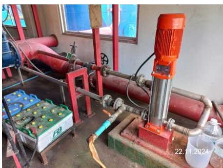
เครื่องสูบน้ำแรงดัน (Jockey Pump)
