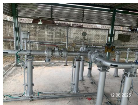
ภาพที่ 2.2-43 ระบบสายดิน
