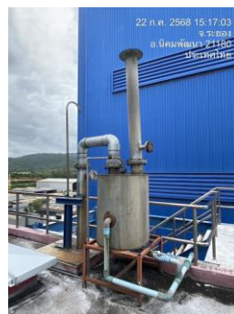
ภาพที่ 2.2-2 ระบบ Scrubber บริเวณปล่องหน่วยถึงเตรียมสารเร่งปฏิกิริยา
