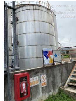
ภาพที่ 2.2-33 คันกั้นล้อมรอบ MEG Tank
