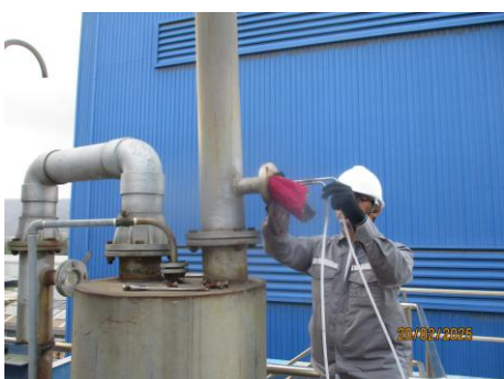
ปล่องระบายของถังเตรียมสารเร่งปฏิกิริยา ของหน่วยผลิต Virgin PET
